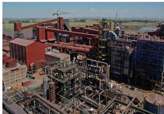
南非 MITTAL 直接还原铁 EPC 项目 MITTAL DRI EPC project in South Africa
