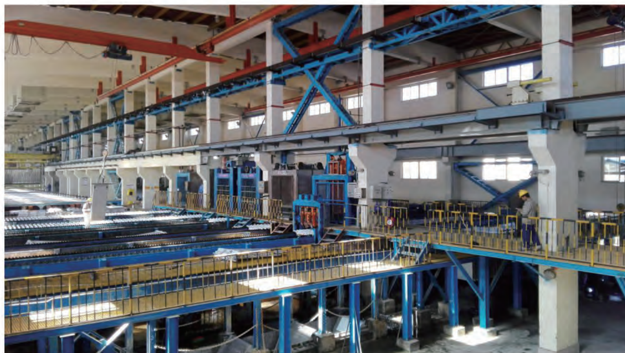
剥锌机 Zinc peeling machine
