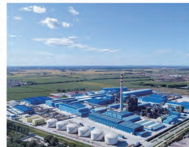
黑龙江紫金矿业齐齐哈尔铜冶炼项目 Heilongjiang Zijin mining qiqihar copper smelting project
