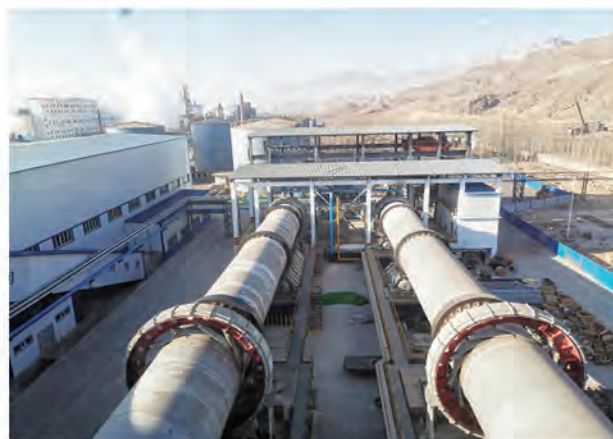
紫金巴彦淖尔锌渣处理项目 Zijin Bayannaor Zinc residue treatment project
